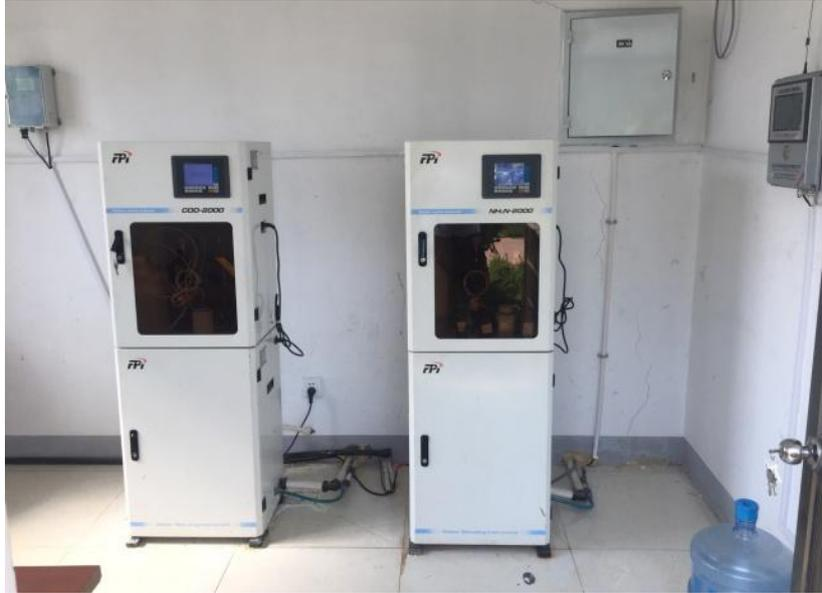
图 11.3 废水在线监控设备
