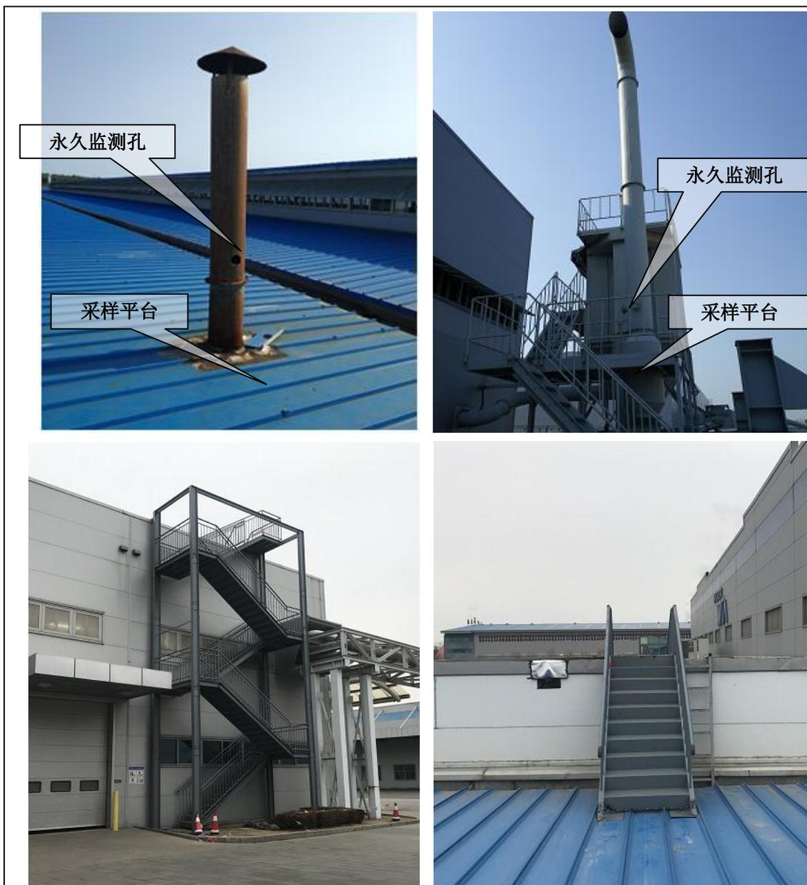
图 11.5 废气采样孔及采样平台
