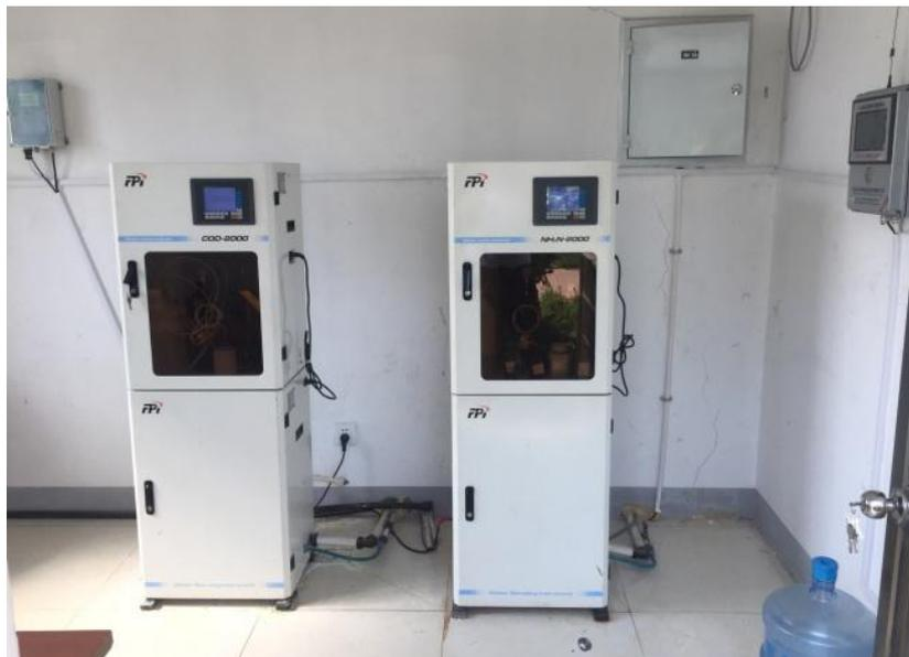
图 11.3 废水在线监控设备
